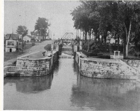
Les mêmes écluses ouvertes.
